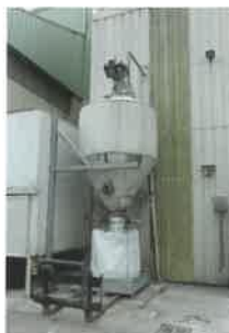
Filters à poussières fines sur le toit.
