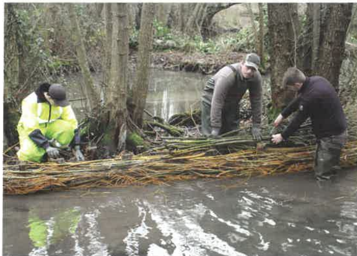
Tressage de saule dans la rivière de la Tronne pour faire barrage.
